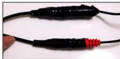
▲ 接続部をビニルテープで 厳重に保護する ※文房具テープは不可 電気工事用をご利用ください。
